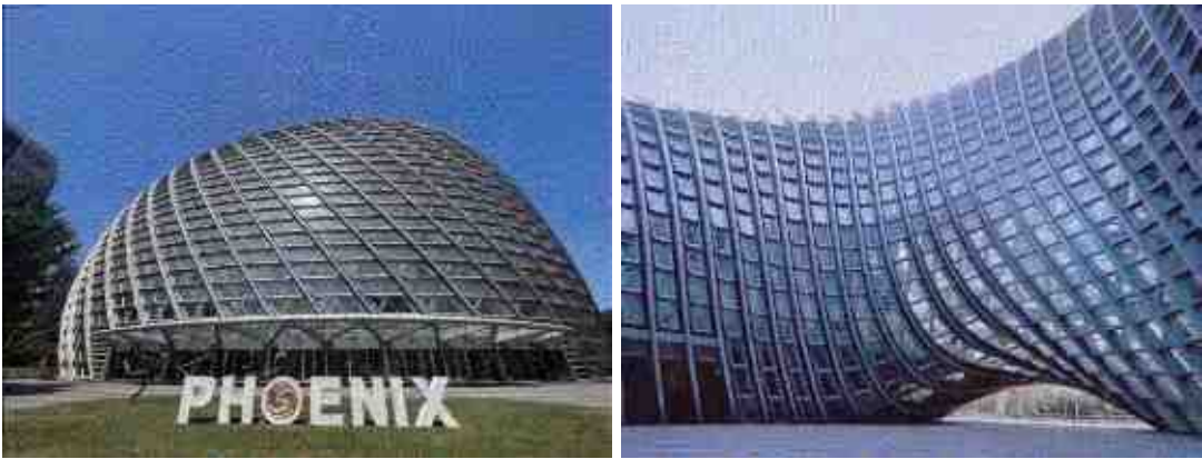
图4.2(a)~(b) 北京凤凰中心外立面雨水引导设计
